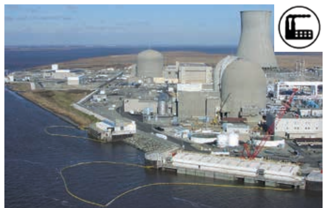
▲ Figura 6: central eléctrica con una toma de agua en primer plano. Se despliegan varias barreras de desviación para evitar la entrada de hidrocarburos.
