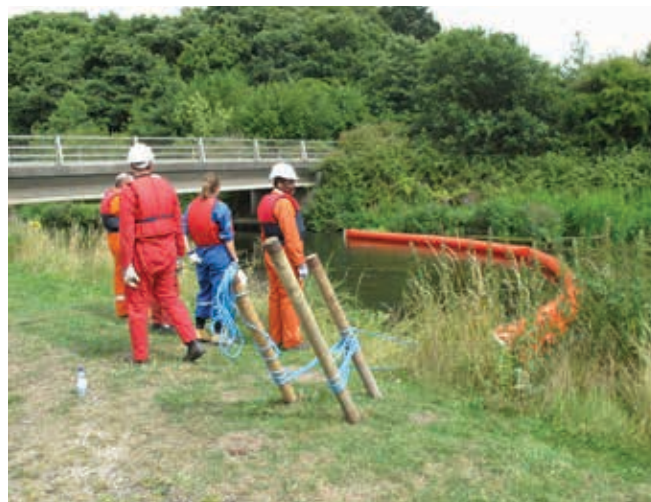
▲ Figura 17: estacas de amarre para mantener la barrera en posición en una costa sin árboles u otros anclajes naturales.
