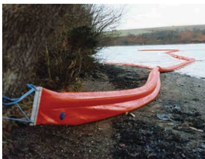
▲ Figura 18: despliegue en un estuario de una barrera de sellado con el litoral. Las cámaras inferiores de lastre de agua permiten que la barrera se asiente sobre la orilla durante la marea baja. En este caso, se conectan secciones de la barrera de sellado con el litoral a secciones de barrera de cortina inflable.
