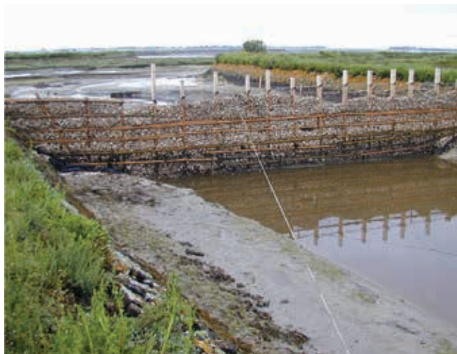
▲ Figura 21: barrera construida con caparzones de ostras, sujeta mediante estacas y redes.
