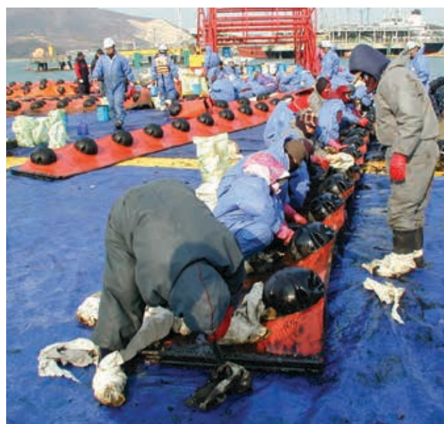
▲ Figura 6: la limpieza de hidrocarburos atrapados detrás de los flotadores externos de la barrera de valla puede resultar particularmente difícil.
