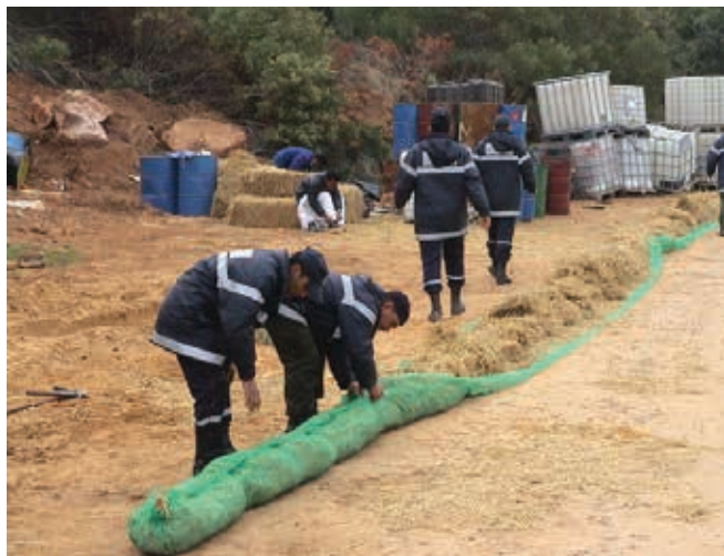
▲ Figura 20: barrera improvisada construida con redes y paja. Aunque no es esperable que resista más de un ciclo de las mareas, puede servir para reducir la contaminación de la costa por la llegada de hidrocarburos flotantes.
