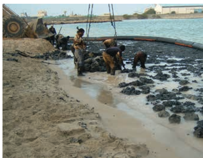
▲ Figura 19: hidrocarburos semisólidos retenidos contra la costa mediante una sección de barrera inflable para facilitar la recolección.
