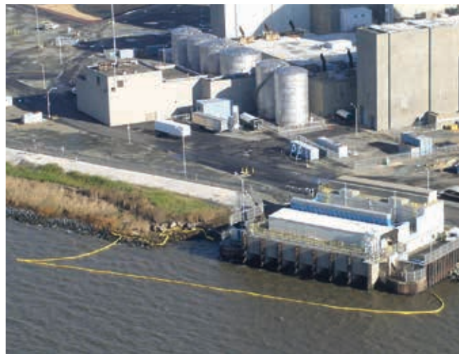
▲ Figura 13: barrera de cortina desplegada delante de la toma de agua de refrigeración de una central eléctrica.
