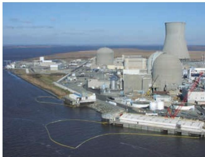
▲ Figura 7: las tomas de agua deben estar protegidas para evitar que los hidrocarburos afecten los intercambiadores de calor, ya que plantean dificultades de limpieza y pueden provocar la parada de instalaciones.
