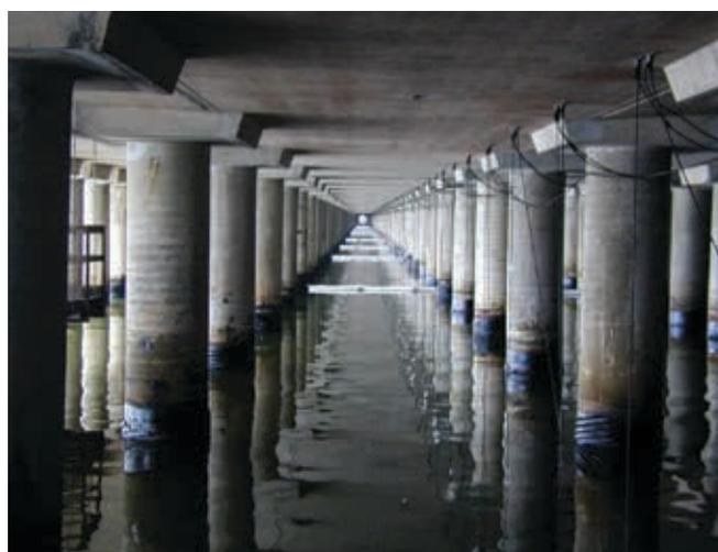
▲ Figura 5: la falta de espacio libre y de ventilación debajo de embarcaderos puede impedir que los operarios de limpieza trabajen de forma fácil y segura.
