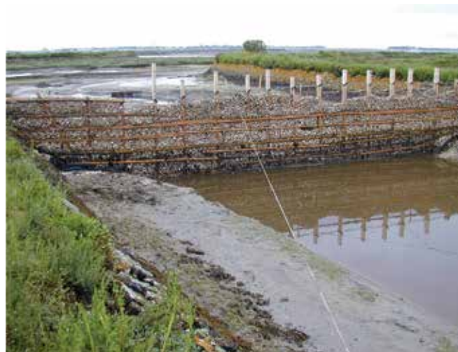
▲ 図21：牡蠣殻で作成されたバリア。杭と網で保持されている。
