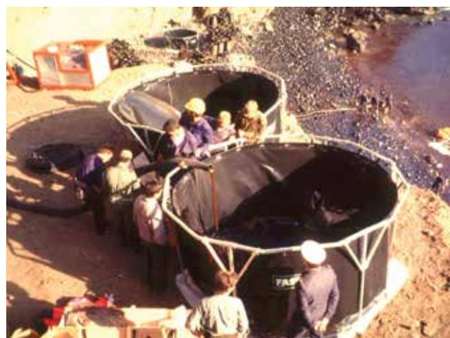
▲ 図28：海岸線で油回収機で回収され、崖の上に設置された一時貯蔵タンクへ移送される乳化した重油。
