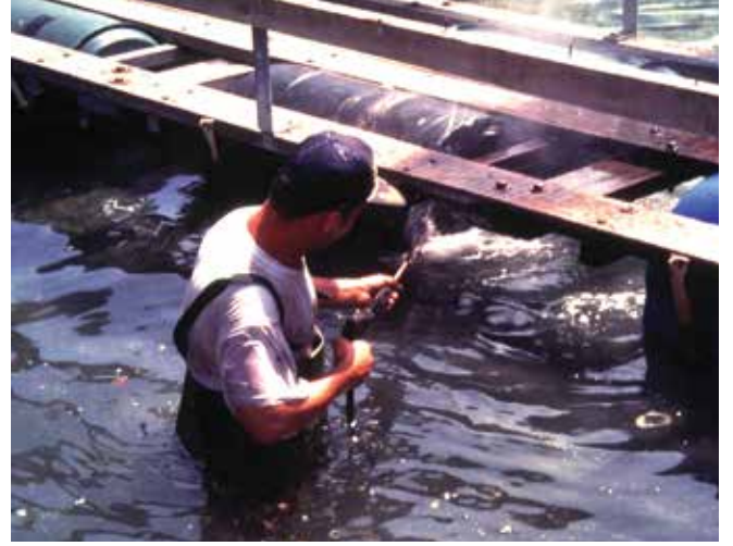
▲ Şekil 11: Deniz ürünleri yetiştirme tesisleri basınçlı suyla yerinde temizleme sayesinde temizlenebilmektedir.
