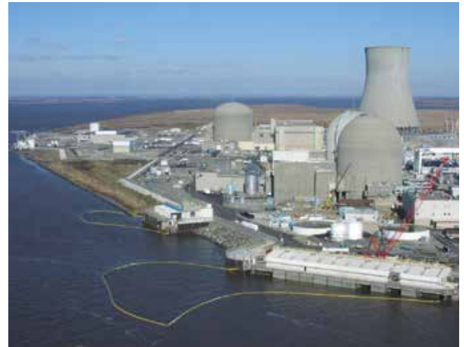
▲ Şekil 7: Petrolün su alma yapılarının temizlenmesi zor olabilecek ve tesislerin kapatılmasına yol açabilecek olan ısı dönüştürücülerini etkilemesinin önlenmesi için korunması gerekmektedir.
