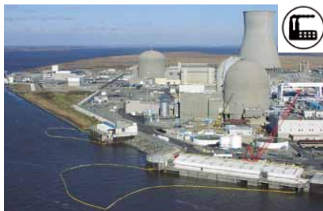
图 6：前面设有取水口的电站。部署了多个绕曲浮木档栅来防止油类进入。
