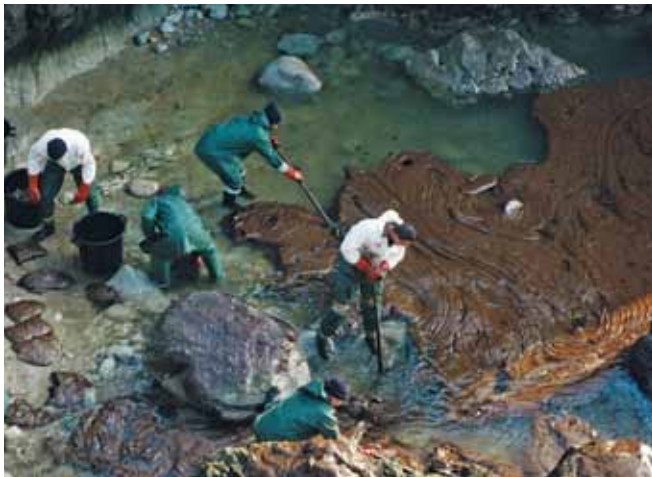
الشكل رقم 8: استعادة نفط الوقود الثقيل مكون لمستحلب ويظهر اللون المميز الأحمر/البني. يبين التحليل أن محتوى المياه في المستحلب يبلغ 50%.
