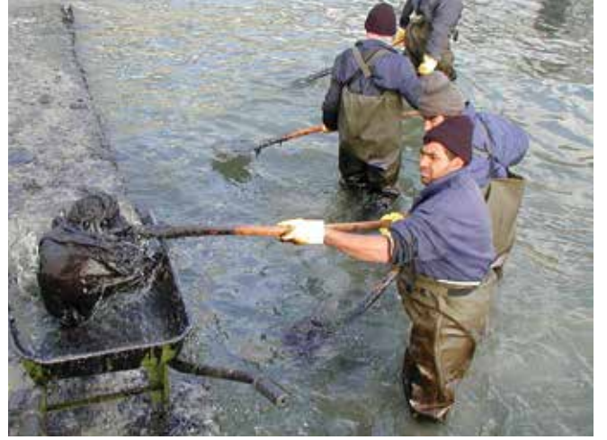
▲ Şekil 9: Batmış ağır yağ yakıtın elle geri alınması.
