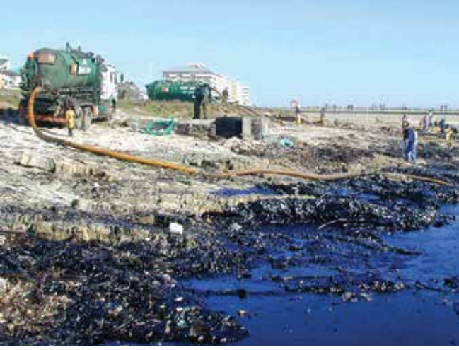
▲ Şekil 8: Vakum sistemlerinin yaygın olarak bulunabilirliği bu cihazları sahil şeridinde veya sahil şeridinin yakınında petrol toplamaya mükemmel bir şekilde uygun hale getirmektedir.
