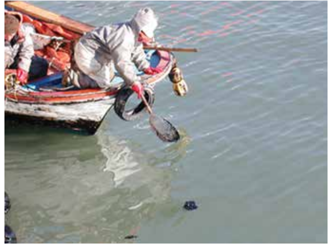
▲ Şekil 22: Yüksek derecede akışmaz olan küçük yağ yakıt kümelerini toplamak için bir ağ keçe kullanan bir balıkçı.
