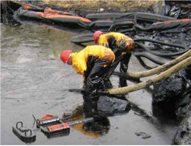
▲ Şekil 10: İşçiler doğrudan petrolün içerisindeki bir vakum pompasına takılan bir hortumu yerleştirirken. Bu örnekte, küçük bent eklentisi sürüklenen suda sonuç olarak olası artış ile birlikte akışmaz yağ yakıtın hortumun içerisine akmasına olanak sağlamak için kaldırılmıştır.
