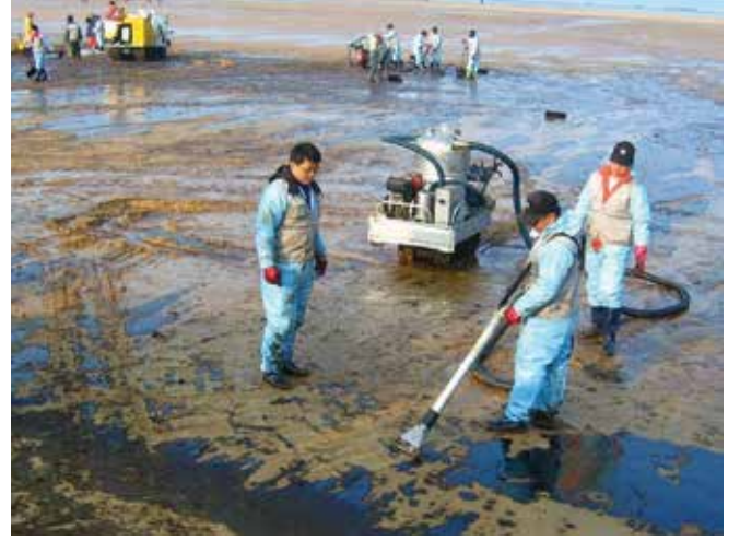
▲ Şekil 9: Seyyar vakum sistemleri kum sahillerde ve kayalık sahil şeritlerinde petrolün toplanmasını kolaylaştırabilmektedir. Boyutu küçültülmüş sistem başka bir şekilde ulaşılması güç olan alanlarda çalışmaya olanak sağlamakla birlikte depolama alanı sınırlıdır.
