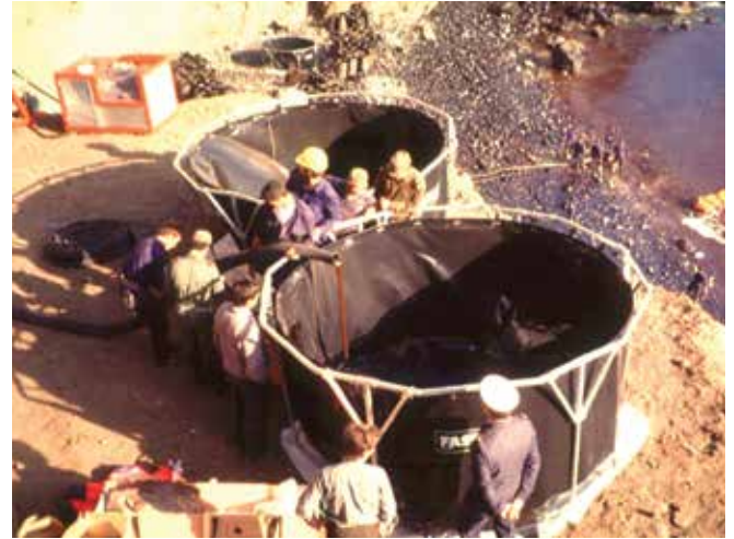
▲ Şekil 28: Deniz süpürücüleri ve pompalar tarafından sahil şeridinden bir tepenin en üstüne yerleştirilen geçici depolama tanklarının içerisine toplanan sütsüleşmiş yağ yakıtı.
