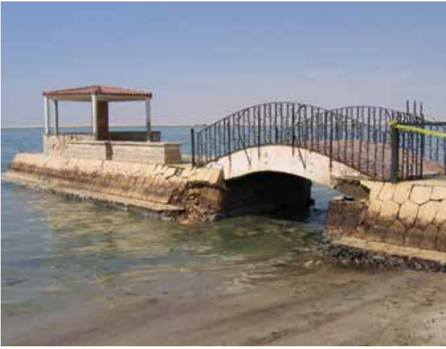
▲ Şekil 14: Taş bir dalgakıranda lekeler bırakan hafif petrol. Bu alg büyümesiyle kolaylıkla karıştırılabilmektedir.
