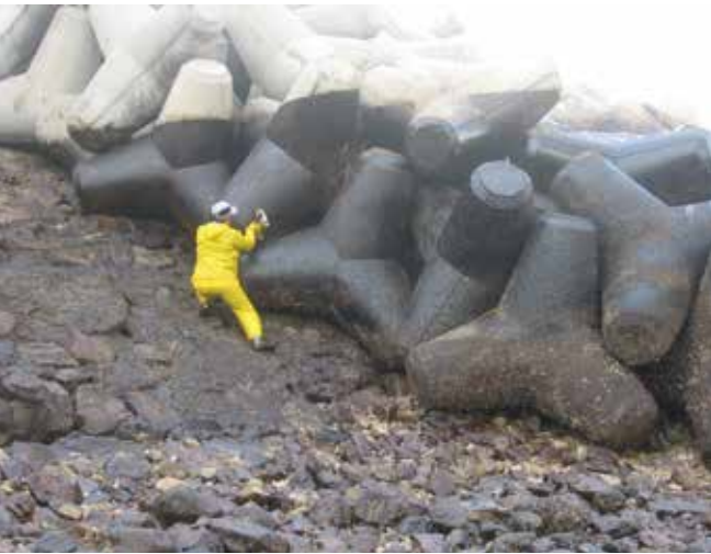
▲ Şekil 29: Petrol, sahile ulaşmış olan gerçek miktarı gizleyen bu dört ayaklı özel beton bloklar gibi sahil koruma yapıları arasında hapsolabilmektedir.
