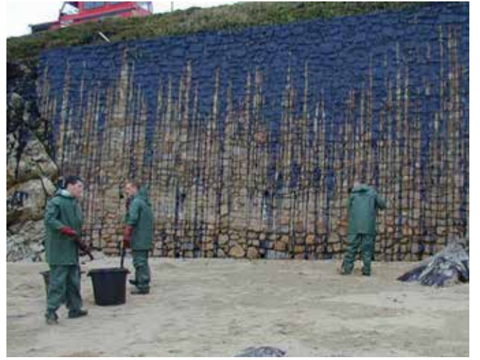
▲ Şekil 15: Fırtınanın neden olduğu bir gelgit sonrasında bir deniz duvarının ağır bir şekilde yağlanması.
