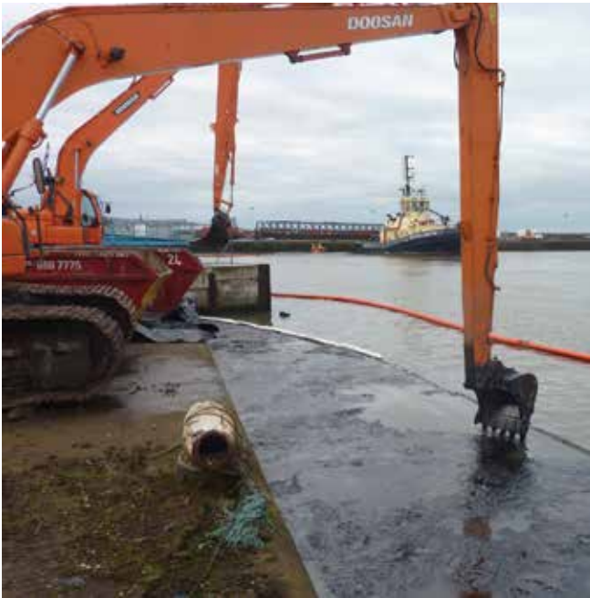
▲ Şekil 5: Petrolün bir liman alanından toplanması için kullanılan inşaat mühendisliği makineleri. Bu durumda, su sıcaklığı petrolün akma noktasının altında olmuştur, petrolü yarı katı hale gelmesine neden olmuş, deniz süpürücülerin kullanımını imkansızlaştırmıştır.
