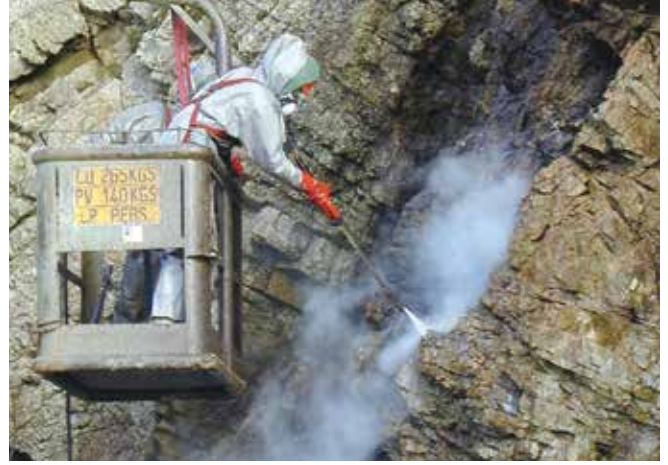
▲ Şekil 21: Bir sosyal tesis kumsalının üstündeki bir sarp kayalık yüzeyinin basınçlı suyla yıkanması. Petrol bir fırtınada sarp kayalığın yukarısına kadar fırlatılmıştır ve temizlik olmaksızın muhtemelen epeyce bir zaman mevcudiyetini sürdürecektir.
