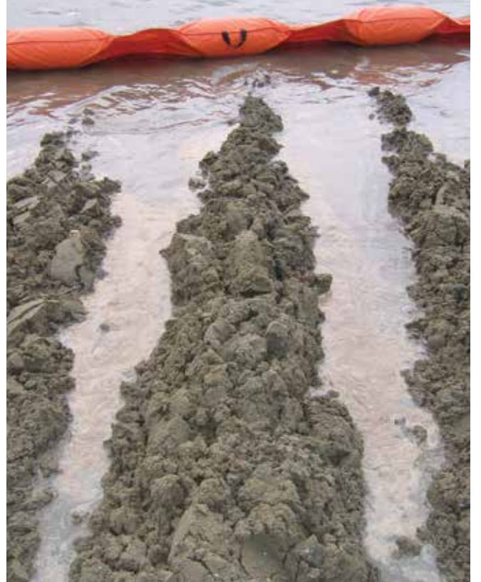
▲ Şekil 25: Kirletilen sahil alt katmanı pullukla sürme sayesinde yüzeye çıkartılmaktadır. Petrol daha sonra suyun kenarından toplama için gelen gelgitte serbest bırakılmaktadır.
