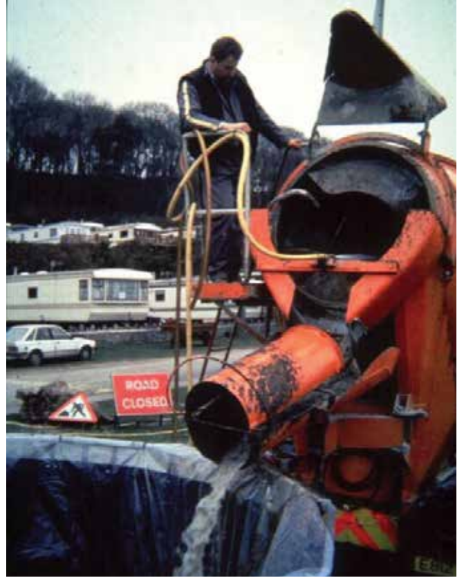
▲ Şekil 24: Çakıl taşları ve küçük kaldırım taşları yıkandıktan sonra atık su bir beton karıştırıcı kamyonundan tahliye edilmektedir.
