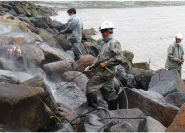
▲ Şekil 32: Yüksek basınçlı yıkama cihazları kullanılarak taş kaplamanın temizlenmesi.
