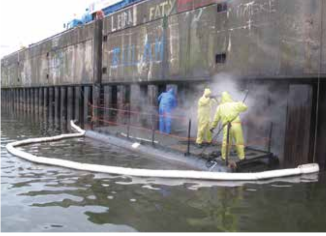
▲ Şekil 30: Küçük bir saldan basınçlı suyla yıkanmakta olan petrol bulaşmış kazıklar ve gemi havuzu iskelesi. Tahliye edilen petrol emici engel içerisinde toplanmaktadır.
