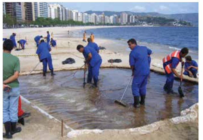
▲ Şekil 16: Bir kum sahile gömülü petrol püskürtme boruları ve delikli borular sayesinde sağlanan basınçlı su kullanılarak gizlendiği yerden çıkartılmaktadır. Alt katman aynı zamanda petrolün sahilden ayrılmasını teşvik etmek için elle de karıştırılmaktadır. Petrol daha sonra çalışma alanını çevreleyen emici engel tarafından toplanmaktadır.
