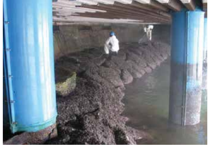
▲ Şekil 31: İskelelerin altına erişim, yeterli boşluk payı ve havalandırma olmaması nedeniyle temizlik personeli için güç ve tehlikeli olabilmektedir.
