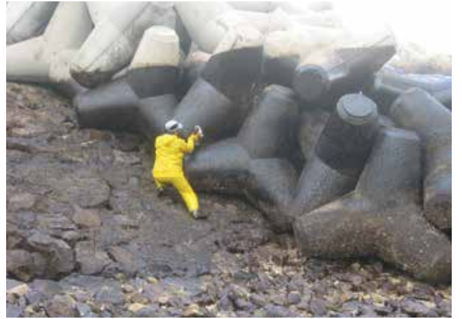
▲ Şekil 33: Petrol bulaşmış olan üç ayaklı sahil koruma yapılarının temizlenmesi sorunu olabilmektedir çünkü yapının içerisindeki petrole erişilmesi zordur.
