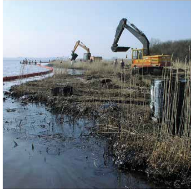
▲ Şekil 41: Sahil şeridinin hassas alanlarında ağır iş makinelerinin kullanılması hatırı sayılır ek hasara neden olabilmektedir. Bu durumda, su yüzeyinde serbest bir şekilde yüzen petrol tabakasının hızlı bir şekilde kaldırılması ihtiyacı bir öncelik olmuştur.
