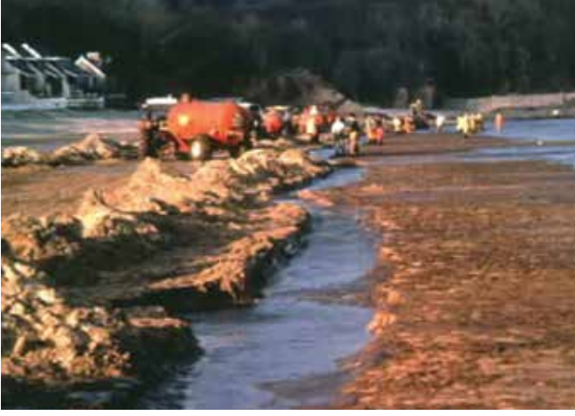
▲ Şekil 4: Hendeklerin içerisine itilmiş ve yıkanarak akıtılmış olan petrolü toplayan zirai vakum tankerleri.
