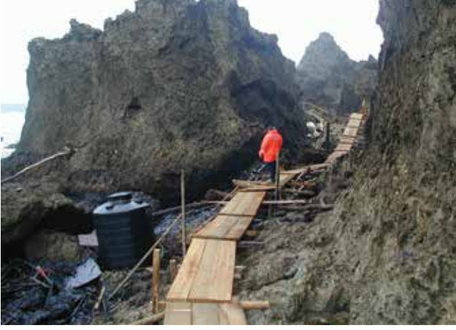
▲ Şekil 35: Kayalık sahil şeritleri üzerinde çalışan işçiler için tehlikelerin en aza indirilmesi için geçici yaya yolları inşa edilebilmektedir.
