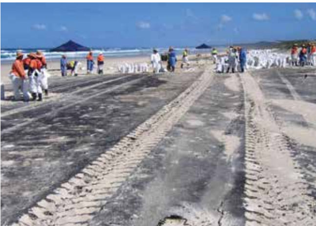
▲ Şekil 6: Petrol bulaşmış olan sahil şeritlerinde makinelerin kullanılması ek kirliliğe neden olabilmektedir. Burada traktörler bir petrol alanın üzerinde sürülmüştür, petrolü kumsalın içine girmeye zorlamaktadır.
