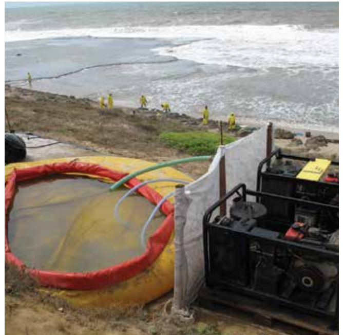
▲ Şekil 22: Uzak bir yerde bir kaya çıkıntısında basınçlı temizleme. Bitişikteki yüksek basınçlı makineler tarafından kullanılacak olan geçici depolama tankına deniz suyu pompalanmıştır.
