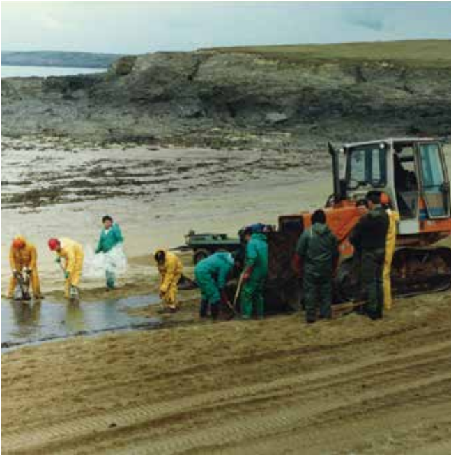
▲ Şekil 44: En iyi hale getirilmiş sahil şeridi temizlik takımı 10 işçi içermektedir, görevin etkin gözetim ve denetimi ve ilerleyişine olanak sağlamaktadır.
