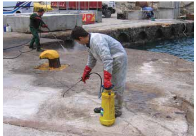
▲ Şekil 23: Basınçlı yıkamayı müteakip bir petrol beneğine uygulanan bir kimyasal sahil hattı temizlik maddesi.
