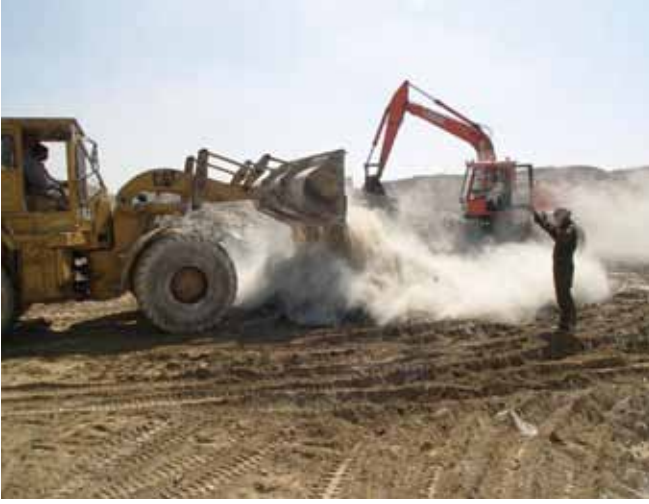
▲ الشكل رقم 18: تثبيت النفايات الملوثة بالنفط باستخدام الجير.
