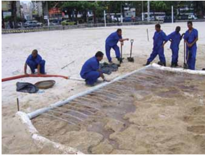
الشكل رقم 1: تنظيف رمال ملوثة بالنفط في الموقع باستخدام الغسيل بالضغط المنخفض، مع وضع حاجز تطويق طافٍ ماص بصورة مناسبة لالتقاط النفط المنبعث.
