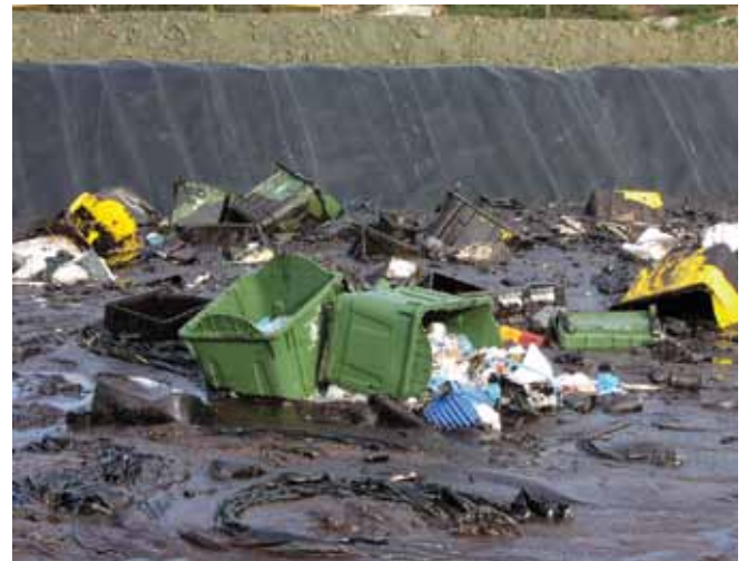
الشكل رقم 9: حفرة مبطنة جيدًا تحتوي على نفايات متفرقة، مما يتطلب جهدًا إضافيًا كبيرًا لفصلها ومعالجتها.
