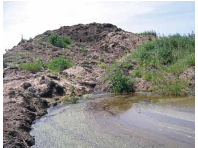
▲ الشكل رقم 13: التقاط ومعالجة النفط المتسرب من رمال ملوثة بالنفط مكمومة في مكان تخزين مؤقت للحيلولة دون حدوث تلوث ثانوي للمنطقة المحيطة والمياه الجوفية
