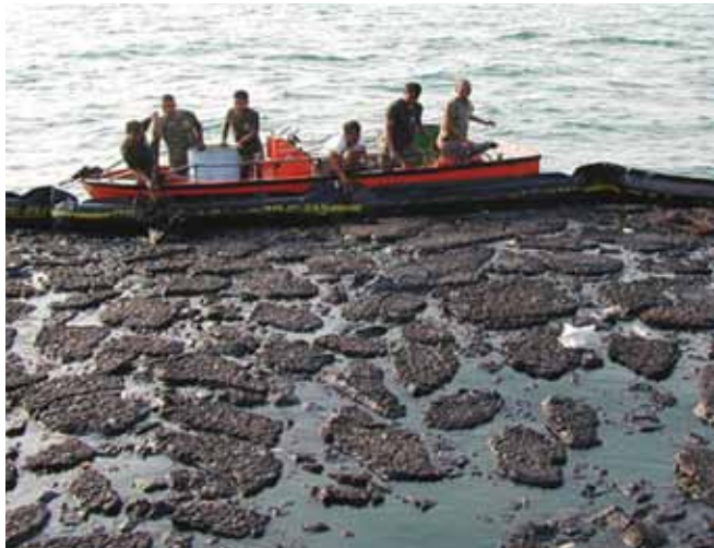
▲ الشكل رقم 6: نفط نصف صلب محتجز بواسطة حاجز تطويق طافي يمكن أن تحد صعوبة ضخ النفط من المسارات المتاحة للتخلص من النفايات.
